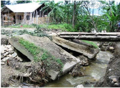
Figure 11: Photo pont à réhabiliter à Shabunda dans le Corridor Sud
