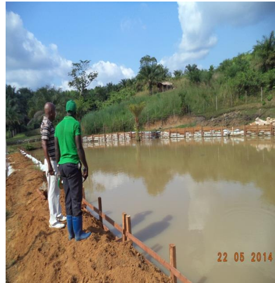
Figure 4: Etang à digues renforcées
