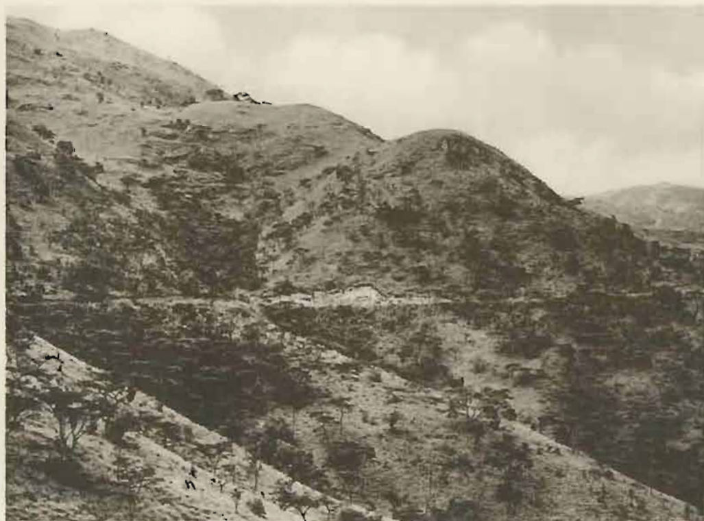
Fig. 24bis. — L'escarpement de Kabasha, Décembre 1934.
